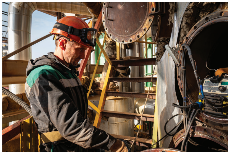
▲ Внутри аппарата использования тепла нейтрализации поз. Р-3 проведён ремонт кислотного и аммиачного барботёров, заменены кислотный трубопровод и дефектные колпачки на реакционных тарелках
