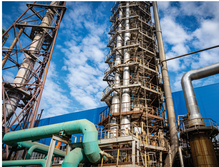
▲ Узлы агрегатов в капремонт часто выглядят, как большие муравейники, где неустанно кипит работа
