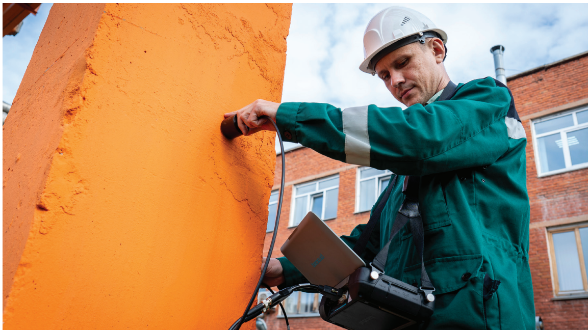
▲ Инженер по испытаниям Владимир Филиппов проверяет прочность бетона при помощи прибора «Pundit PL-200»
