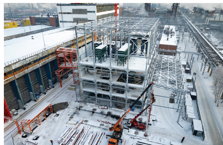
▲ Строительство нового цеха в самом разгаре
