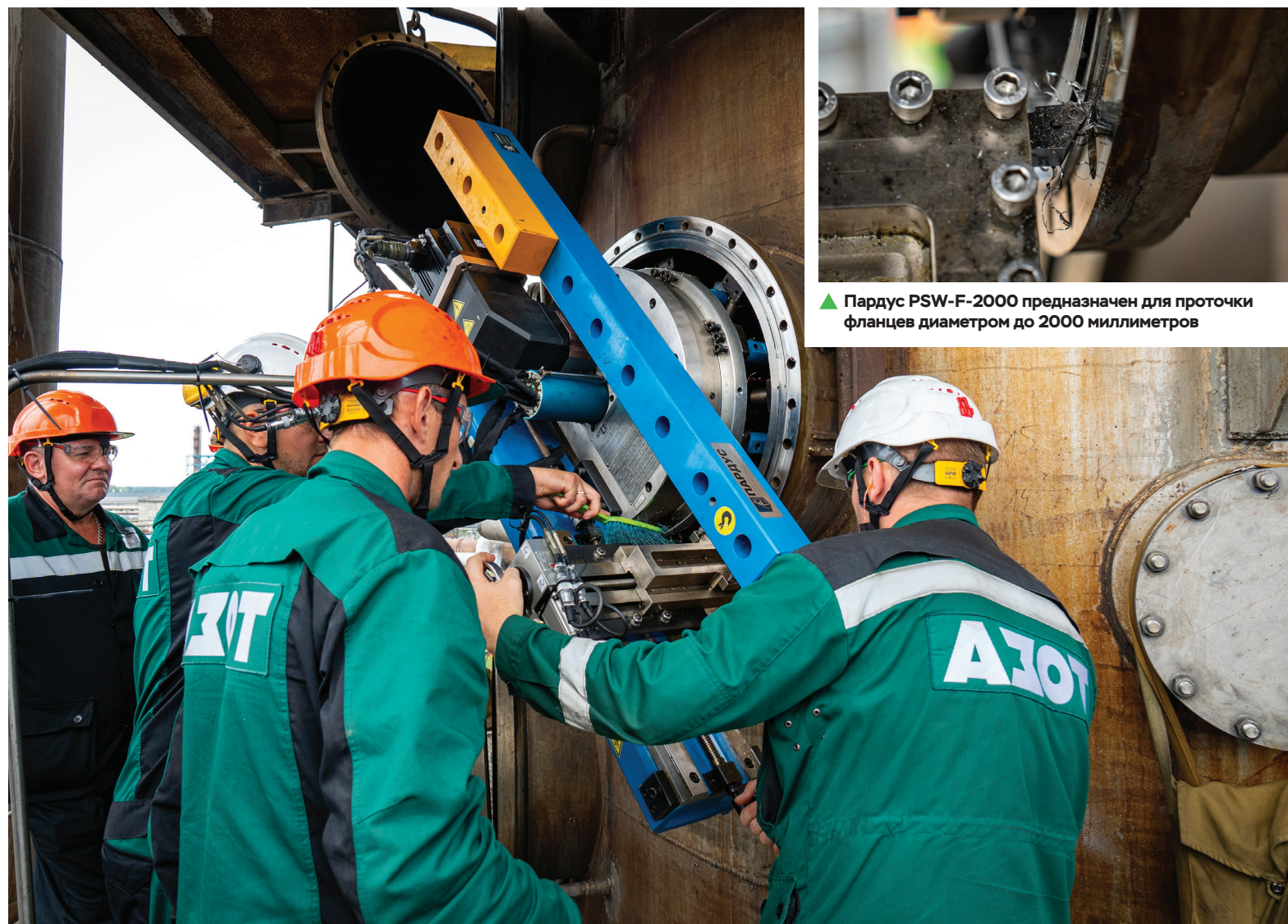
▲ Мобильный станок позволяет проводить ремонт на месте, без демонтажа и перемещения оборудования
