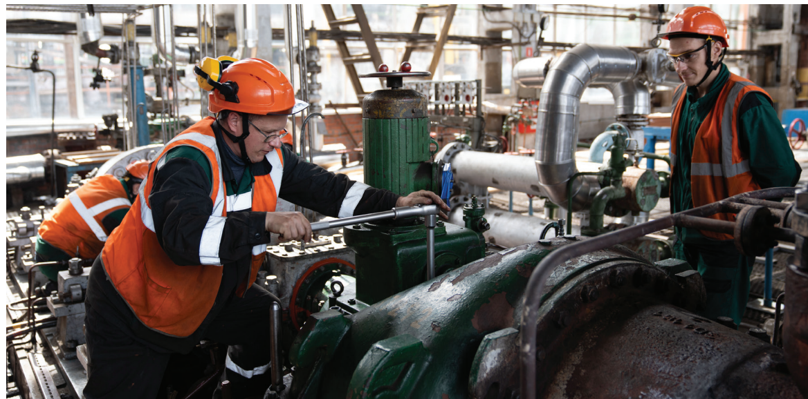
▲ Плановое техобслуживание главной движущей силы агрегата — турбокомпрессоров
