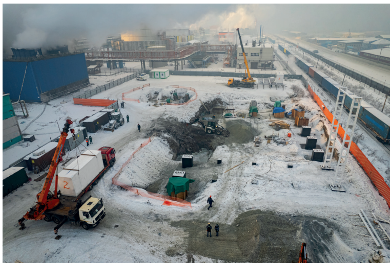
▲ Так сейчас выглядит строительная площадка новой установки с высоты птичьего полёта
