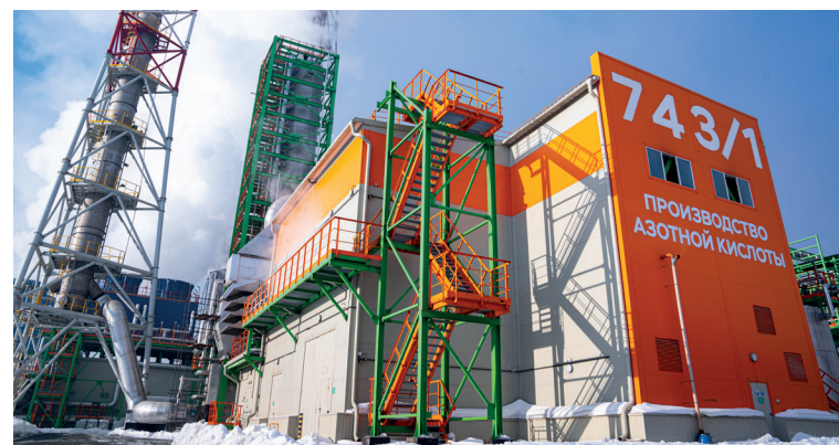
▲ В ближайшие 2 года в цехе № 15 пройдёт большая реконструкция, которая сделает производство азотной кислоты более экологичным
