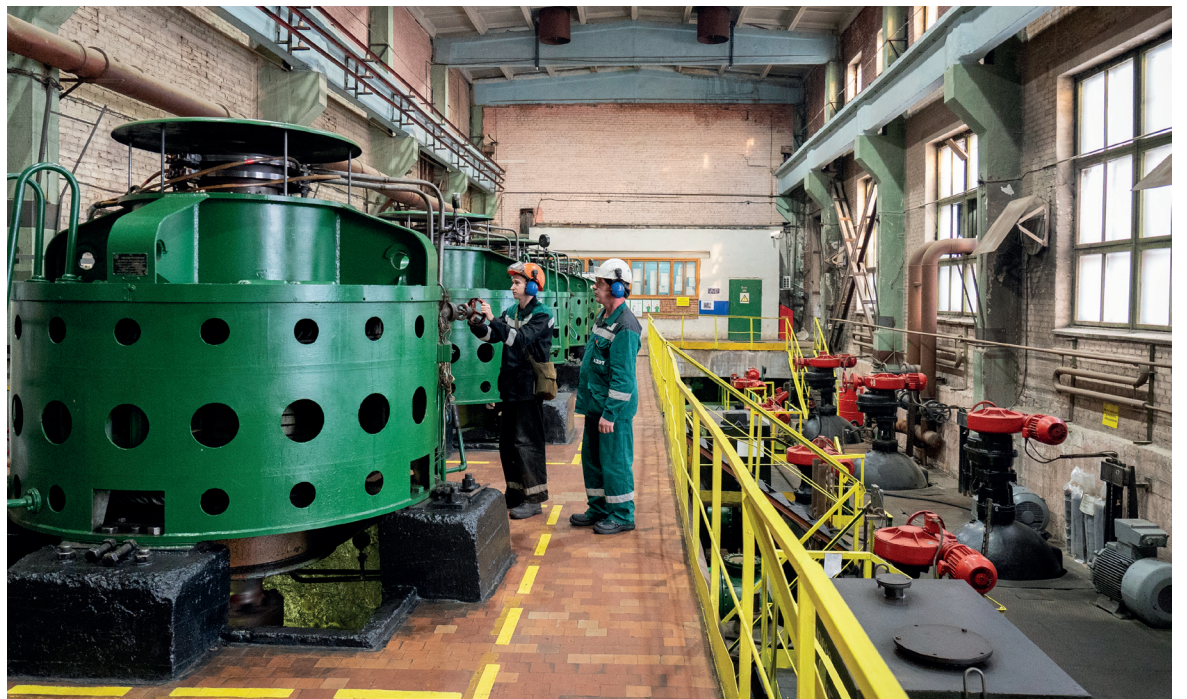
▲ На насосной станции ВОЦ-19 прошла генеральная уборка
