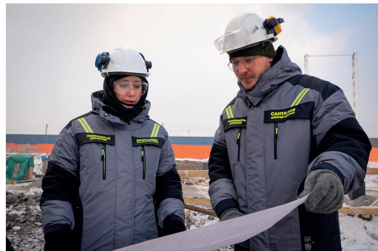
▲ Надежда Протасова и Дмитрий Санталов на строительной площадке «Большого ЖУКа»
