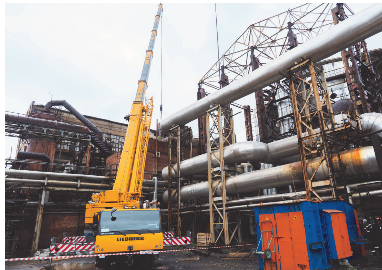
▲ Для замены четырёхтонной задвижки по серному газу был привлечён кран «Либхерр»
