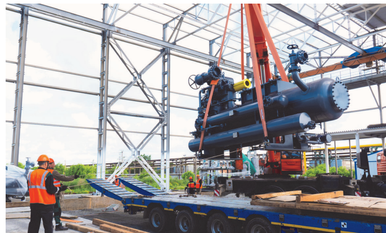
▲ Стройка кипит: ведётся монтаж основного технологического оборудования
