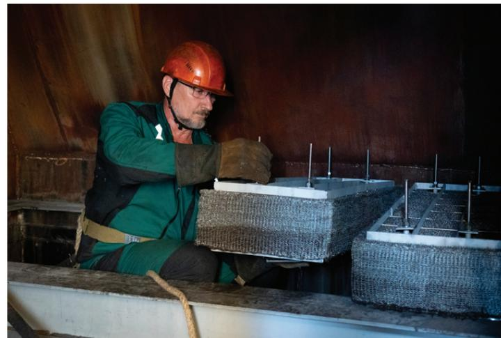
▲ Реконструкция шестой секции скруббера позиции X-29 снизит объёмы выбросов цеха № 13
