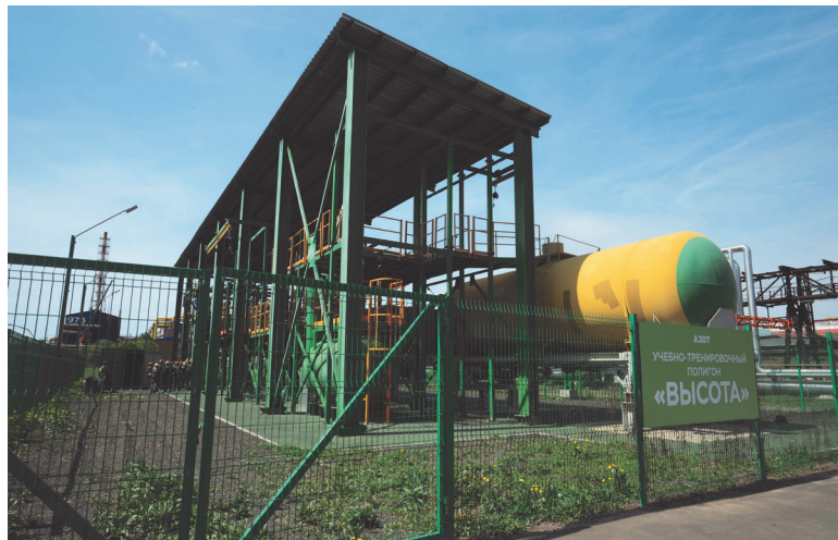
▲ Полигон имеет 10 учебных зон для отработки безопасных методов и приёмов выполнения работ на высоте
