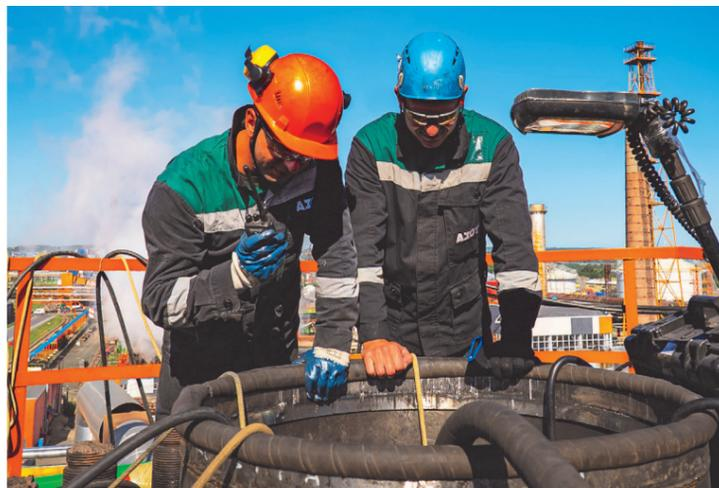
▲ Сложная работа по выгрузке катализатора на колонне синтеза цеха аммиака-2 оказалась под силу только нашим газоспасателям
