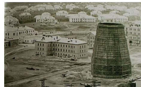
▲ Вид на строящийся посёлок Предзаводской
