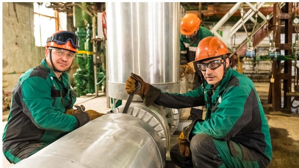
▲ Бригады цеха теплоснабжения работают над устранением дефектов на трубопроводах
