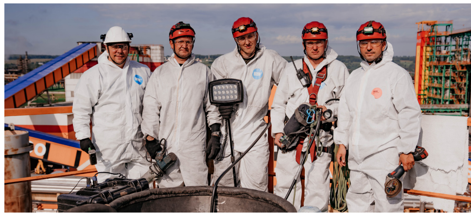
▲ Газоспасатели «Азота» выгрузили катализатор из колонны синтеза за рекордные 4 суток
