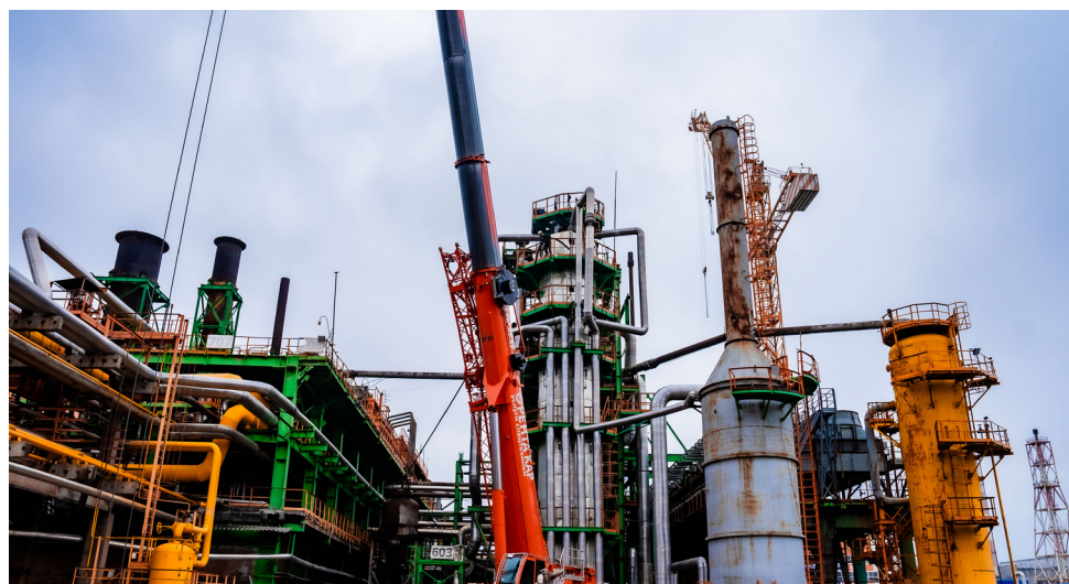
▲ Ремонт колонны синтеза позиции 601 — главная лимитирующая работа в рамках плановой остановки цеха аммиака-1
