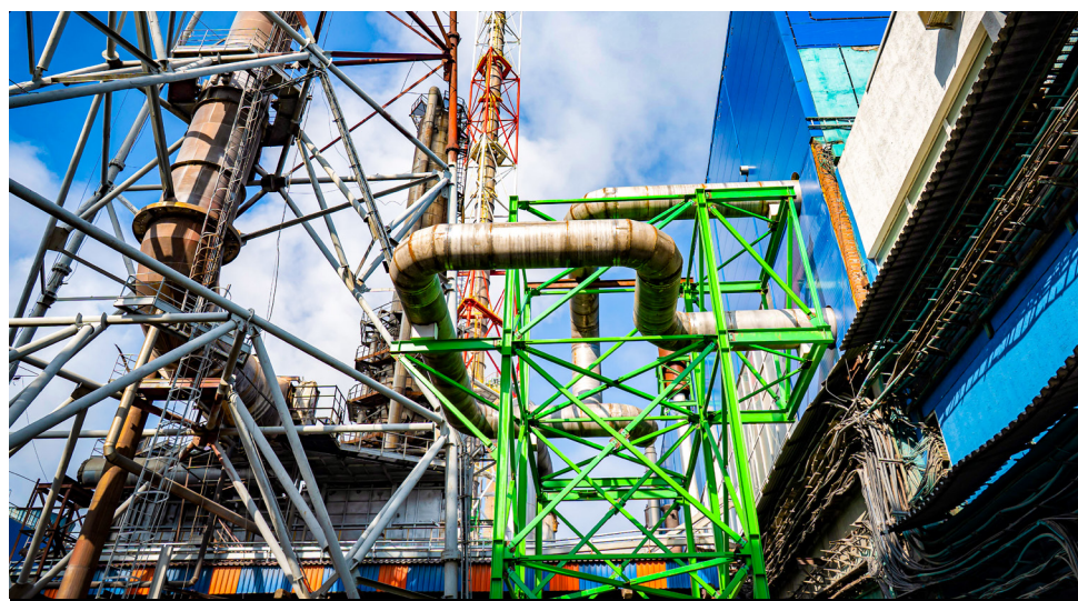
▲ Эти новые трубопроводы соединят цех № 15 и систему низкотемпературной очистки
